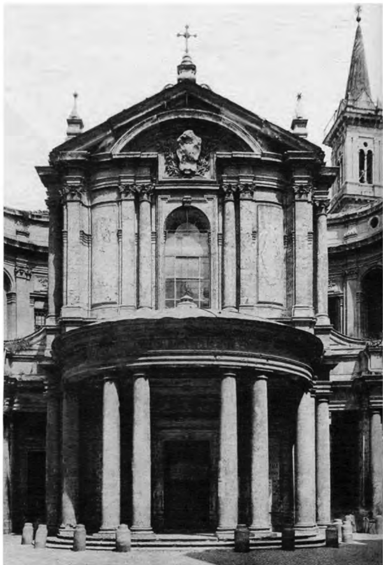
28. П. да Кортоня . Санта Мария делла Паче. Начало строительства — 1655
